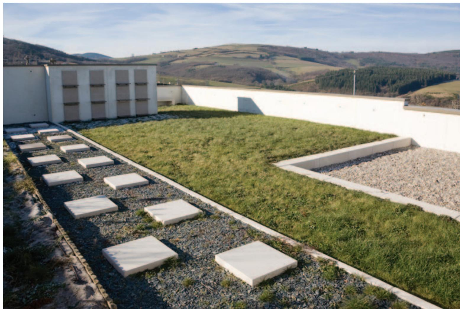
Le parking paysager favorise l'infiltration des eaux pluviales et participe à l'intégration du cimetière au paysage de coteaux du Pilat. Une seconde entrée située côté route dispose d'un emmarchement en béton blanc rejoignant l'extension. L'utilisation du schiste (murs de soutènement) et du béton de couleur blanche (référence à la pierre de comblanchien des anciens caveaux) conforte l'intégration du projet à son environnement.
