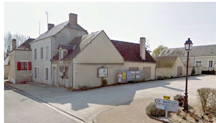
Bâties existants avant la création du commerce multiservice. © Google Maps
