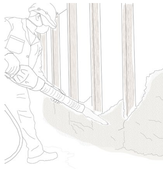
Projection de béton de chanvre
